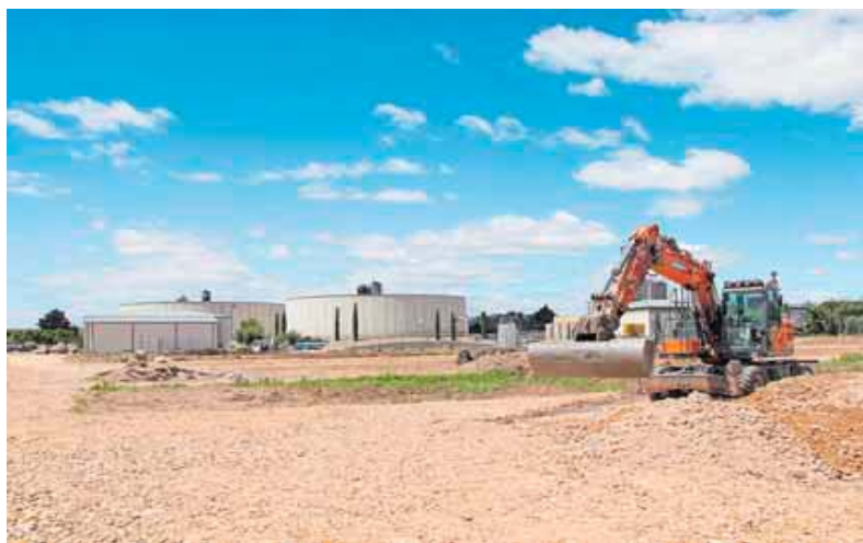
Imagen tomada durante la tarde de ayer de los trabajos iniciados por Nilsa junto a la depuradora. BLANCA ALDANONDO
