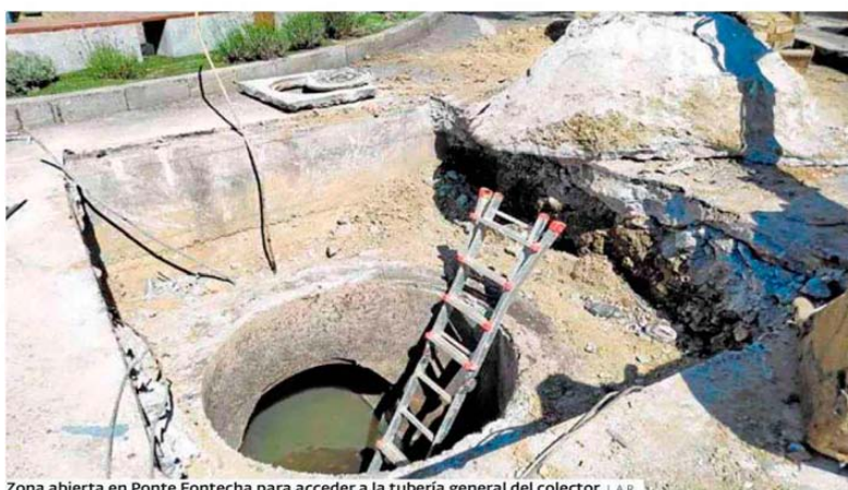
Zona abierta en Ponte Fontecha para acceder a la tubería general del colector. L.A.R. 12/07/2024
